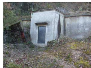
Ce réservoir possède deux cuves d'une capacité totale de 300 m<sup>3</sup>. Il alimente gravitairement la plaine de Labahou et le réservoir Labahou par l'intermédiaire de la reprise de Labahou.
