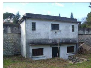
Ce réservoir possède deux cuves d'une capacité totale de 1000 m<sup>3</sup>. Il dessert gravitairement la ville et le quartier de Plan des Moles.
