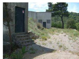
Ce réservoir possède deux cuves d'une capacité totale de 800 m<sup>3</sup>. Il alimente gravitairement la zone de Travillargues et la bache de reprise de l'Olivier.
